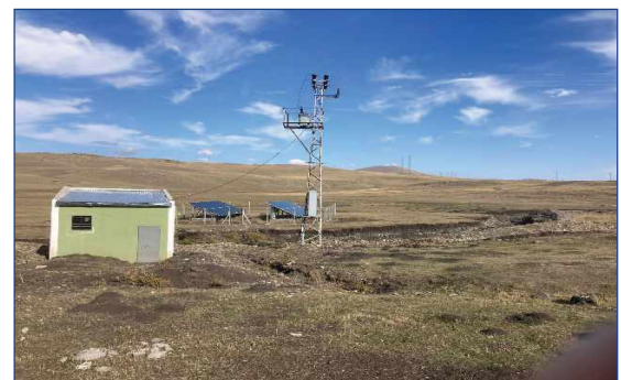
Şekil 5. İçme suyu terfi binası ve PV panellerin yer aldığı sistemin bir fotoğrafı
